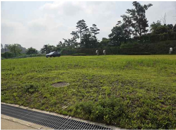
배수지 상부 현황
