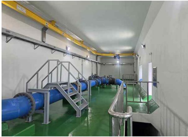
유입밸브실 내부 전경
