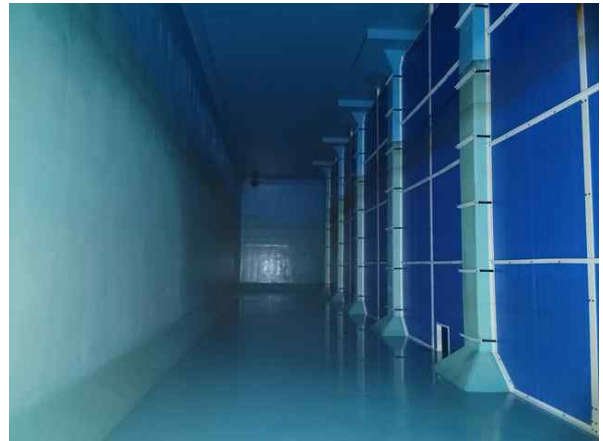
배수지 2지 내부 전경
