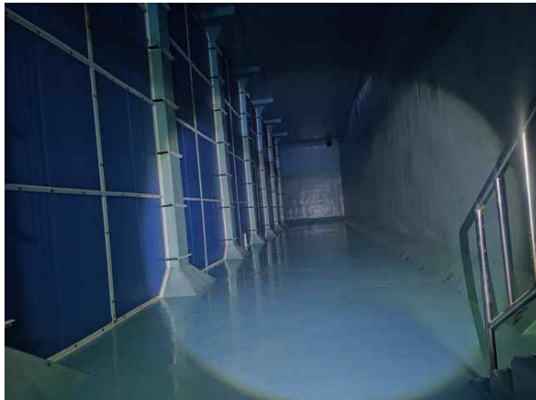
배수지 1지 내부 전경
