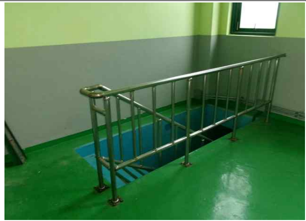
검수실 내부 전경
